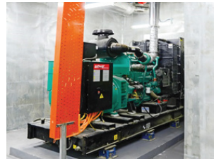
Lắp đặt máy phát điện dự phòng
