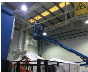
Lắp đặt hệ thống ống gió lạnh
