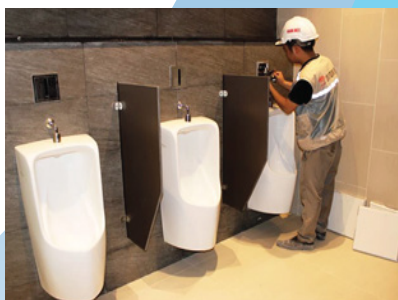
Lắp đặt thiết bị nhà vệ sinh
