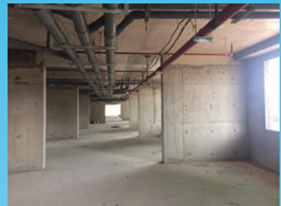
Lắp đặt hệ thống thoát nước sinh hoạt
