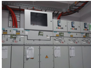
Lắp đặt hệ thống tủ điện phân phối
