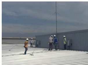
Lắp đặt hệ thống chống sét
