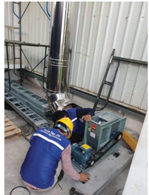
Lắp đặt hệ thống quạt thống gió loại ly tâm, hướng trục
