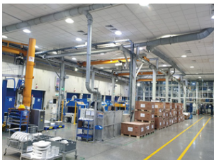
Lắp đặt hệ thống đèn chiếu sáng
