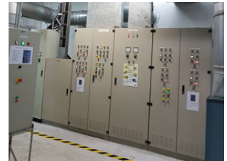
Lắp điện tủ điện cấp nguồn thiết bị
