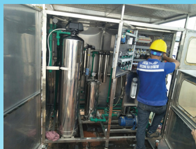
Lắp đặt hệ thống lọc nước tinh khiết RO
