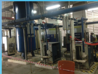
Lắp đặt hệ thống máy nén khí
