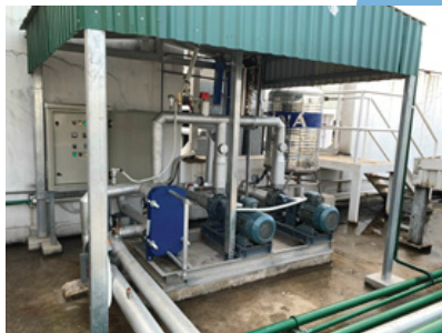
Lắp đặt hệ thống lạnh trao đổi nhiệt dạng tấm
