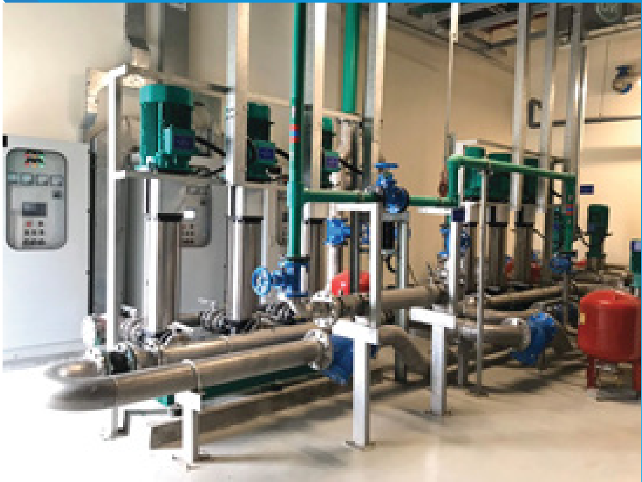
Lắp đặt hệ thống bơm nước sinh hoạt
