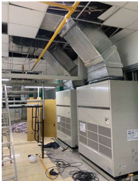
Lắp đặt hệ thống quạt thống gió loại ly tâm, hướng trục
