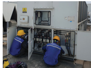
Lắp đặt hệ thống làm lạnh máy Chiller, tháp giải nhiệt
