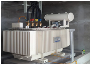
Lắp đặt trạm biến áp
