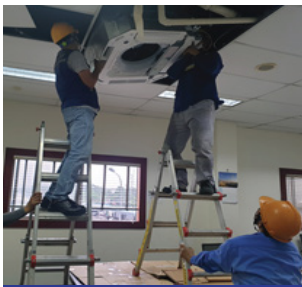
Lắp đặt hệ thống máy điều hòa trung tâm VRV
